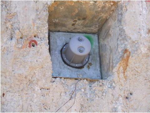
Nell'installazione dei cap in applicazioni EC è richiesto che il dispositivo sia incassato in un recesso, per garantire una maggiore protezione agli urti accidentali o vandalici.
